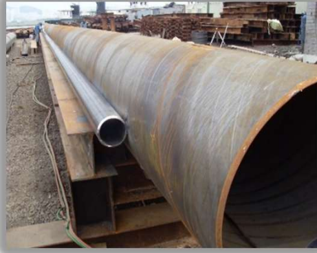
▶ 계수관 가공 및 용접이음
