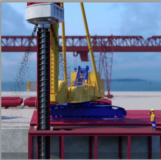
▶ 본 Pile 오거 굴착 및 수직진동 직항타 동시 시공
