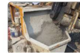
slump 5cm 이하의 Mortar 배합
